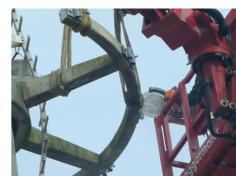
Firma Miersch zum Einsatz einer Husqvarna K970 Benzin-Handsäge mit einer Schnitttiefe von 270 mm. Somit musste nur eine Trennsäge mit knapp 14 Kilogramm, ein Diamanttrennring und ein Benzinkanister in die Höhe transportiert werden.
